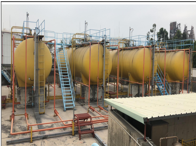
主体工程（液氨储罐及泵区）
