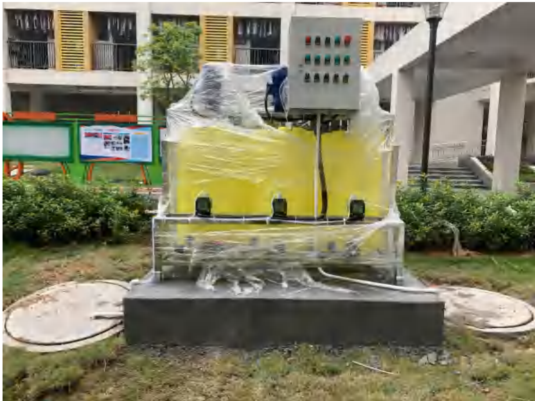
酸碱中和+混凝沉淀装置
