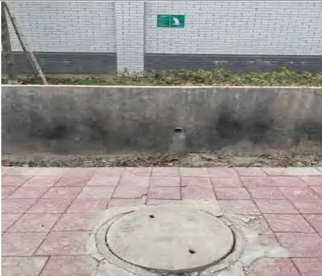
综合废水排放口
